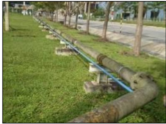
ภาพที่ 13 แนวท่อก๊าซธรรมชาติสำหรับเตาผิงเหล็ก (RHF)
